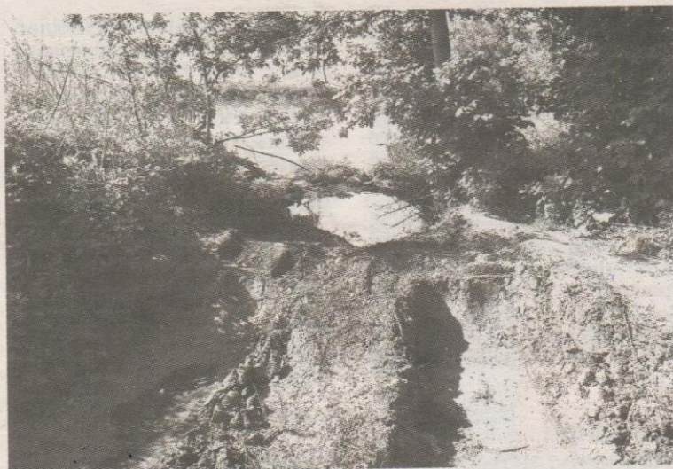
Место, куда сливают канализационные нечистоты
